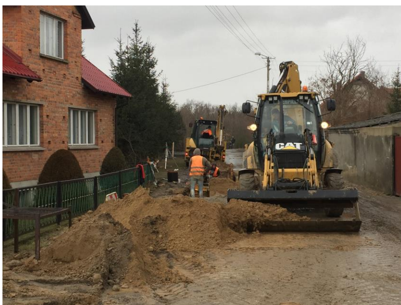
Fot. 1 Budowa sieci kanalizacji sanitarnej na ul. Leśnej w Dłużynie
