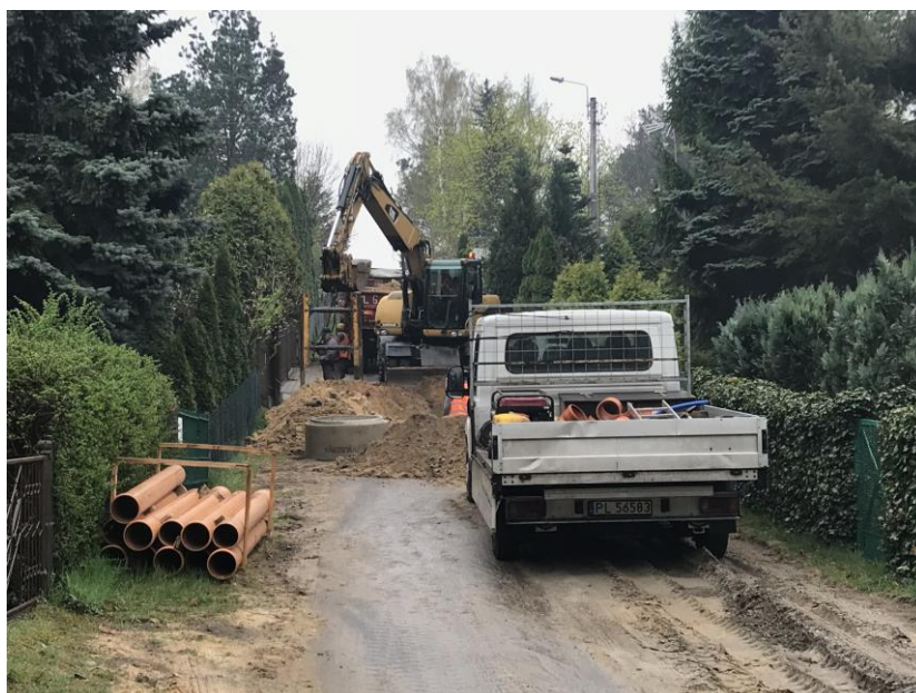
Fot. 4 Budowa sieci kanalizacji sanitarnej na ul. Wiosennej w Boszkowie-Letnisku
