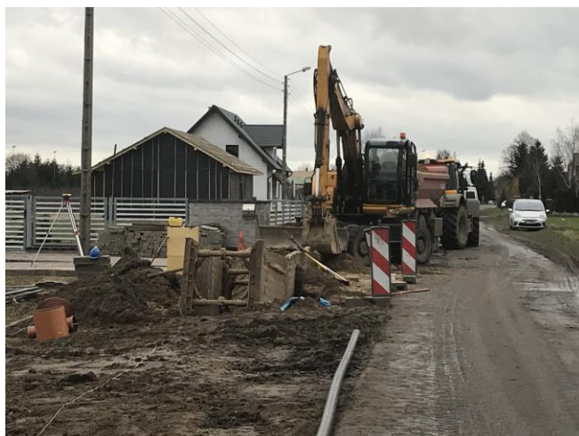
Fot. 3 Budowa sieci kanalizacji sanitarnej na ul. Szkolnej w Krzycku Wielkim
