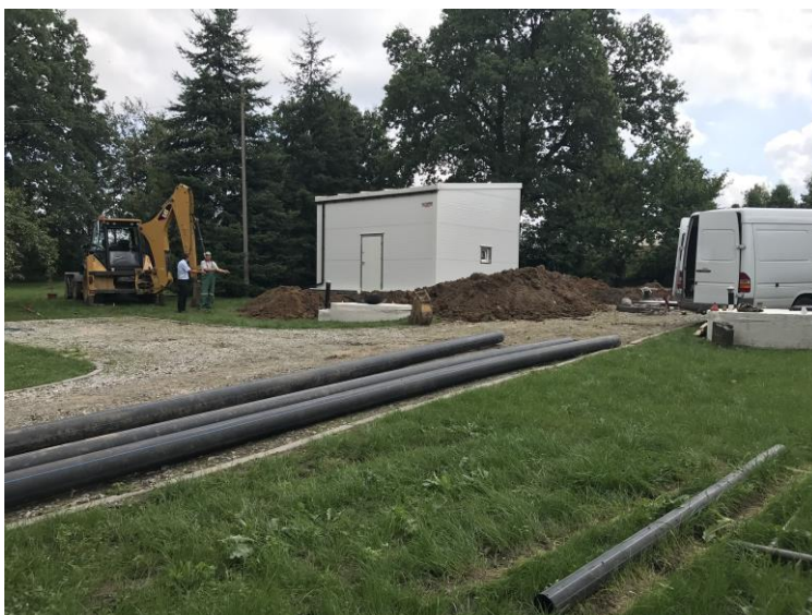
Fot. 2 Roboty modernizacyjne na Stacji Uzdatniania Wody we Włoszakowicach
