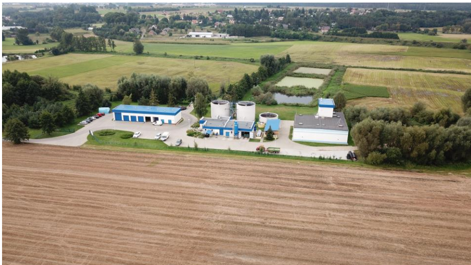
Fot. 5 Oczyszczalnia ścieków w Grotnikach
