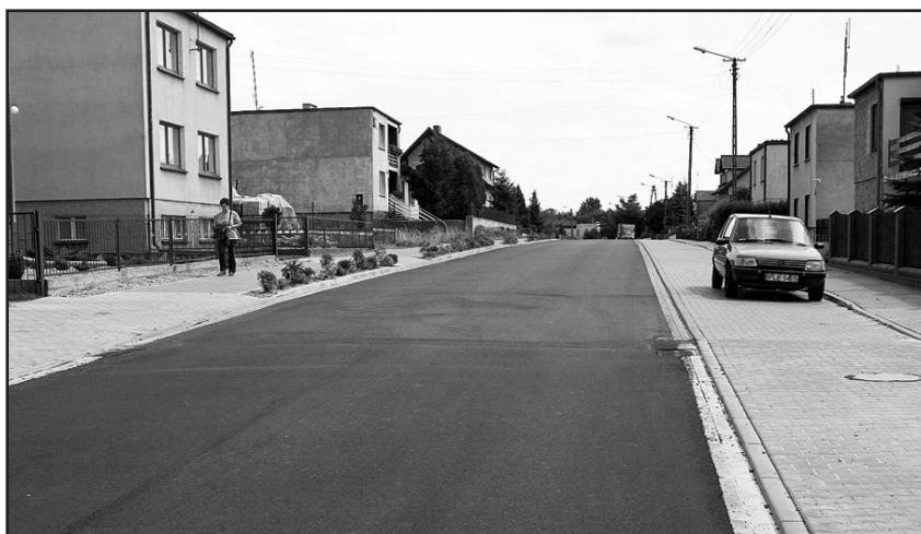
W 2008 r. zakończono przebudowę ul. Grotnickiej we Włoszakowicach. Na zdj. widoczne szerokie chodniki i asfaltowa jezdnia, miejsca parkingowe oraz kanalizacja deszczowa w pasie drogi
